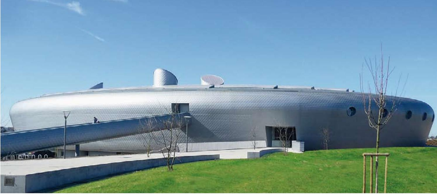
▲ Die geschlossene Seite von „Les Thermes“ mit dem Eingangsbereich: In die Dachdeckung sind etwa 500 m<sup>2</sup> photovoltaische Elemente integriert
