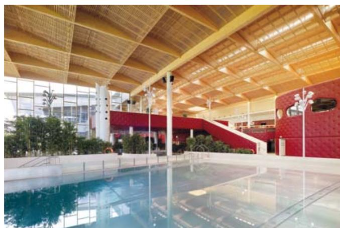
▲ Geneigte Gitter aus Holzlamellen dienen als Akustikpaneele. Senkrechte Holzlamellengitter schließen den Bereich bis zu den Lichtbändern
